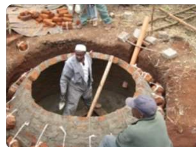
Bau von Biogasanlagen für Haushalte in Kenia
